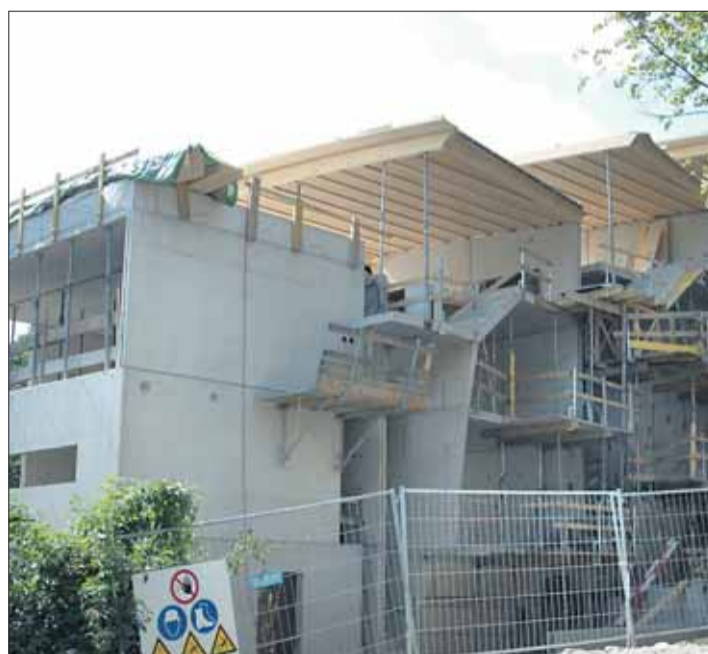
An der Stelle dieser Wohnanlage im Stadtteil Hötting stand früher lediglich ein Gartenhaus. Uwe Schwinghammer
