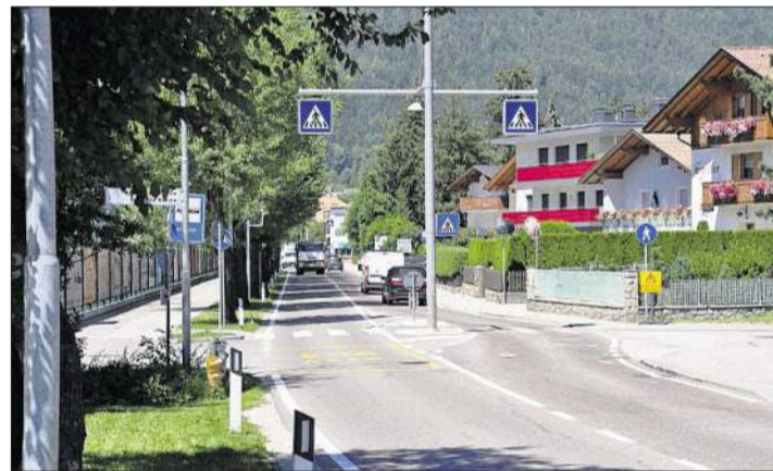
Das Bild trägt: Die Straße durch St. Georgen wird an Spitzentagen von 17.000 Autos befahren.
